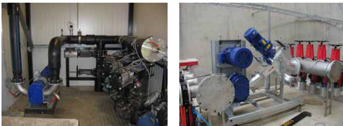
Slika 7.9. Sustavi za pumpanje
