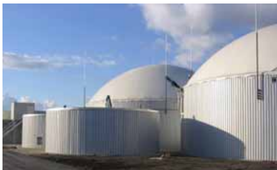
Slika 7.19. Vertikalni fermentatori pokriveni membranom koja ne propušta plin (lijevo: napuhana membrana i desno: membrana pričvršćena za stup)
